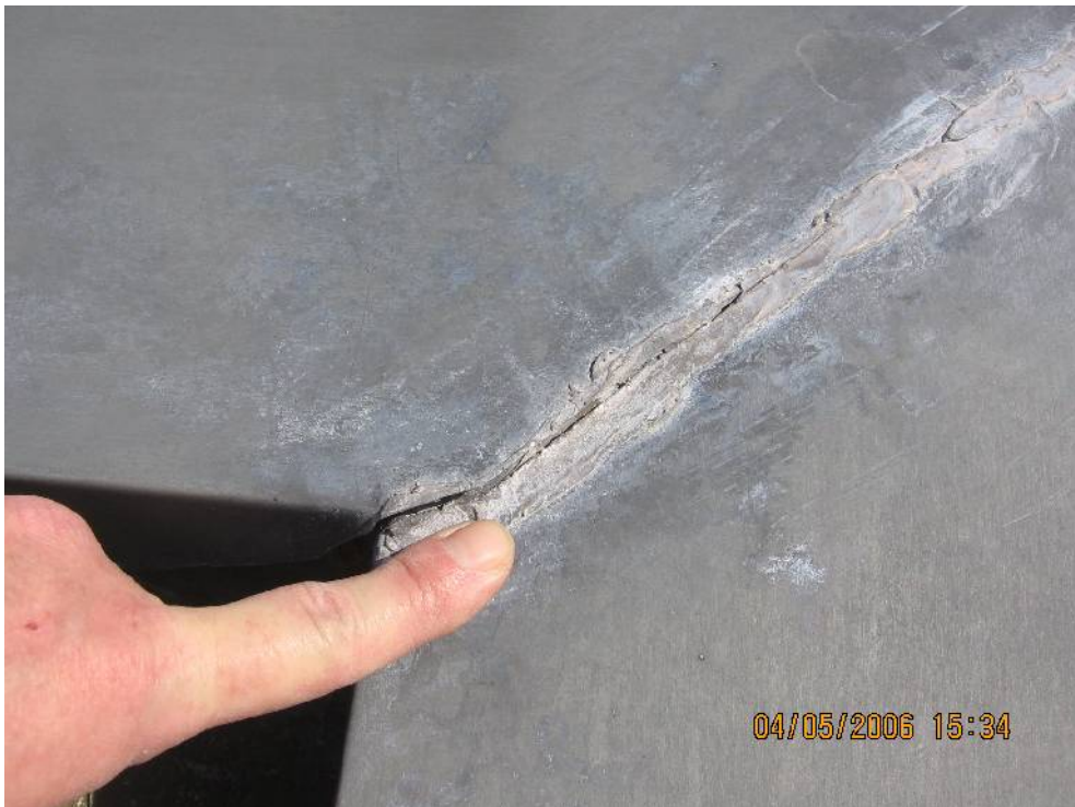
Abbildung 23: Gerissene Lötnaht
