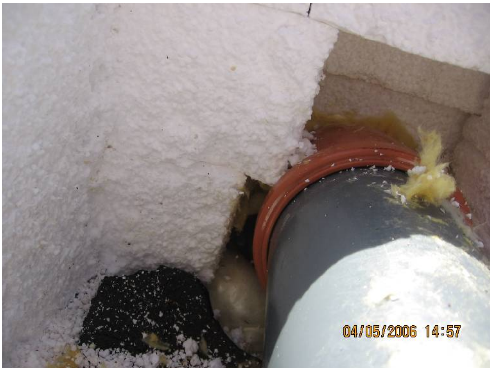
Abbildung 19: Übergang in das senkrechte Rohr, PU-Schaum
