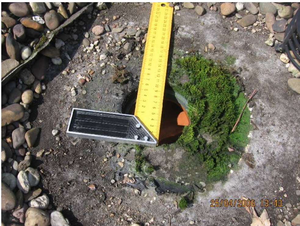
Abbildung 13: Erhöhter Dachablauf
