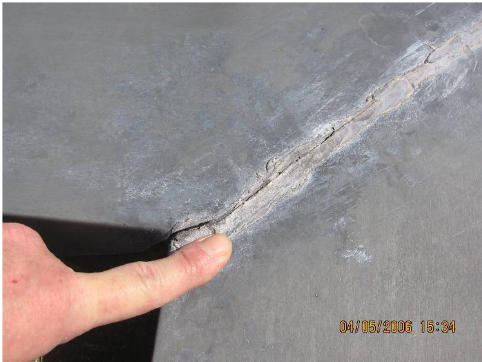
Abbildung 5: Gerissene Naht
