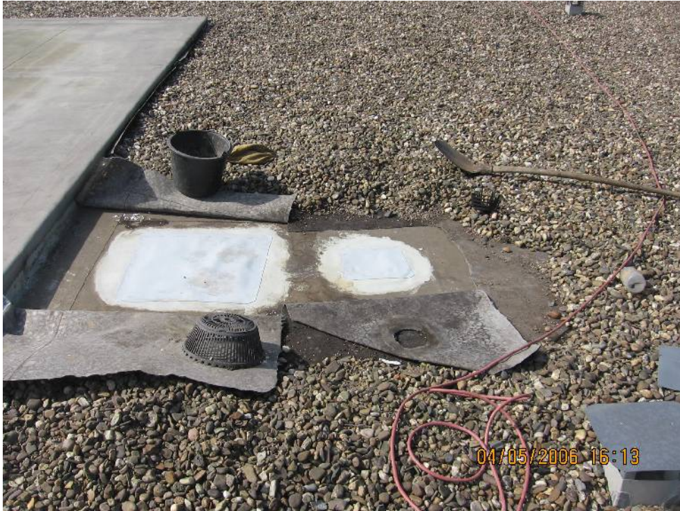
Abbildung 22: Ablauf zunächst verschlossen
