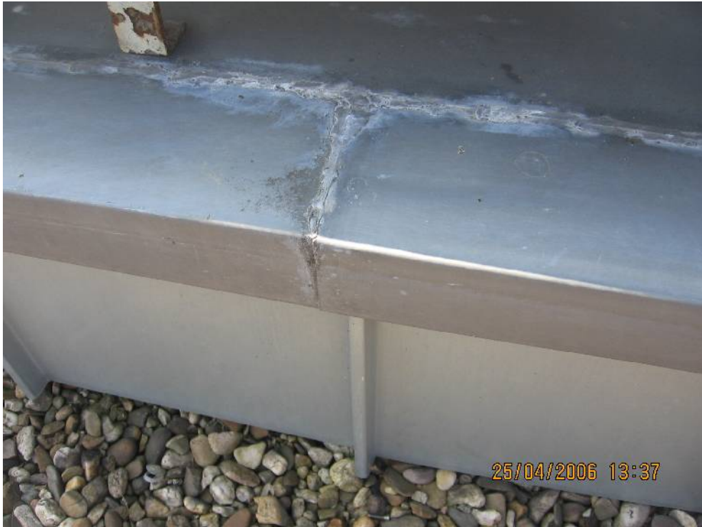
Abbildung 12: Nicht fachgerechte Lötnaht
