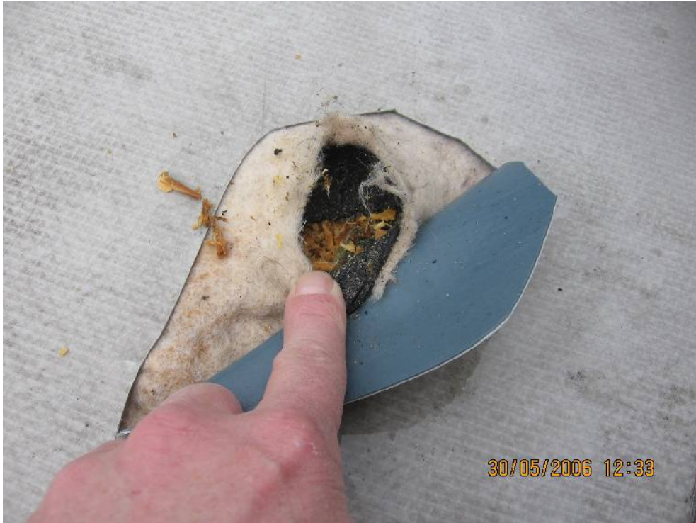
Abbildung 28: Verfaultes Holz
