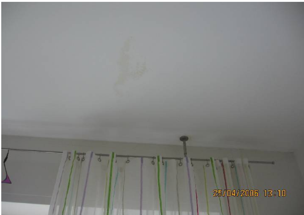
Abbildung 11: Feuchtflecken Decke
